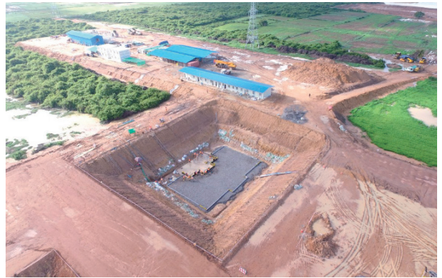
建設中の排水池
