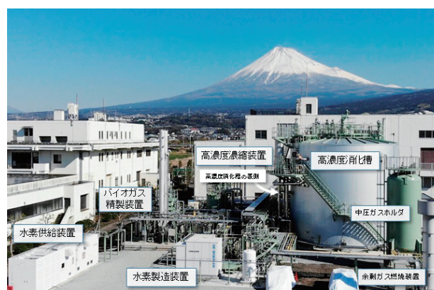
写真1 実証施設全景
