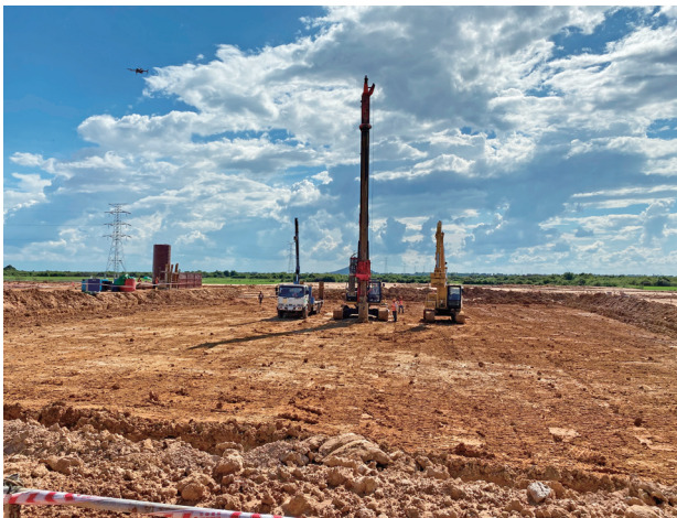
浄水池建設予定地
