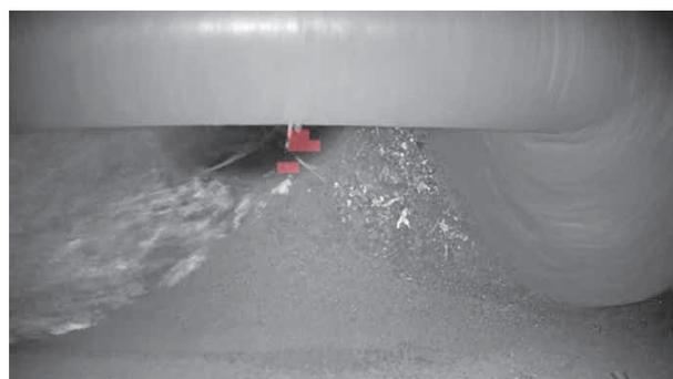
図8 不燃物貯留槽下スクリーユの異常検知状況
