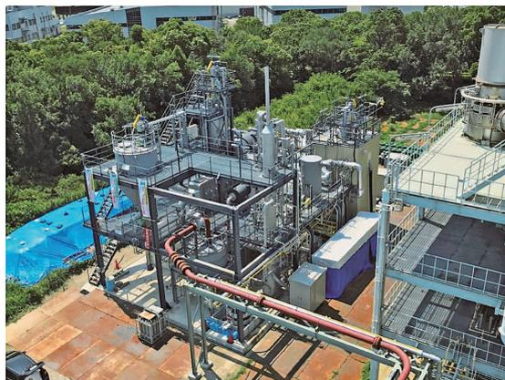
写真2 汚泥燃料化システム実証設備外観 (脱水汚泥処理能力10 t-wet/d)
