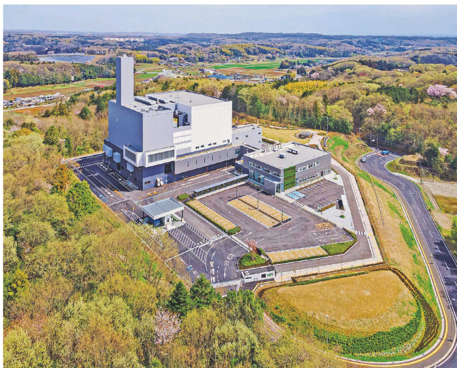
埼玉西部クリーンセンターの外観
