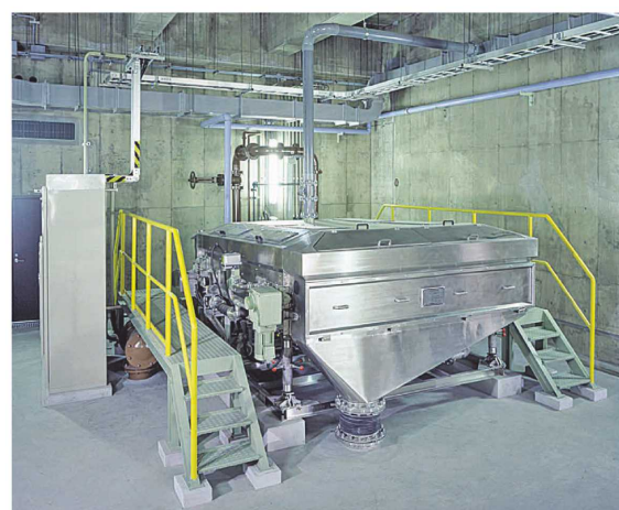
写真3 ベルト型濃縮機
