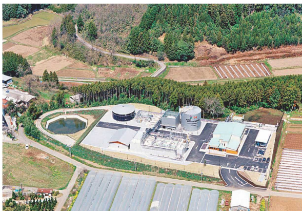
写真6 日田市バイオマス資源化センター
