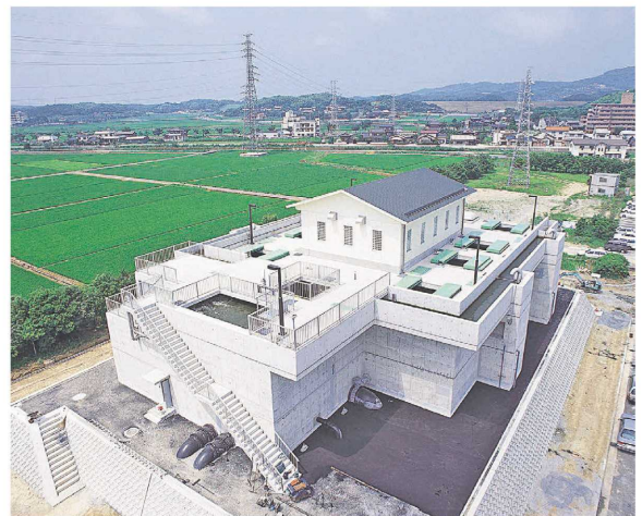
写真12 生物接触ろ過設備 BCF
