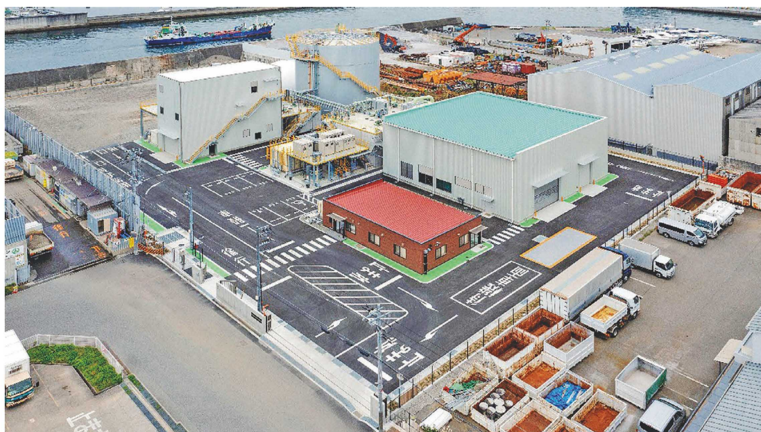
バイオガス KOBE 外観写真
