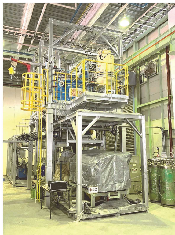
図3 炭酸化・資材化実証設備
