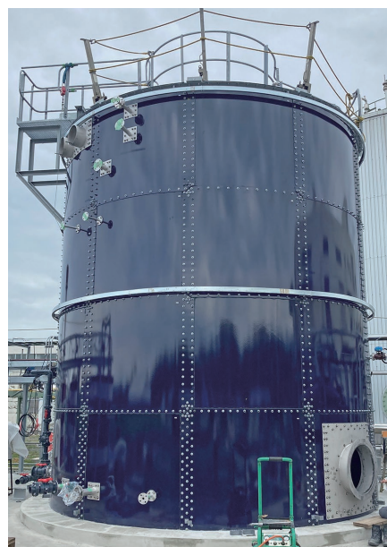
ブルーダイジェスターの外観 （保温材施工前）
