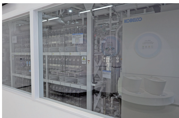
写真5 SH-100D-G IIの設置状況
