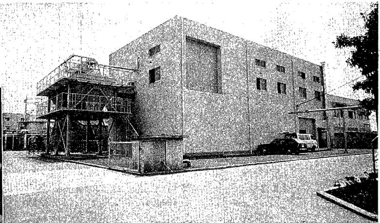
▲ 写真 3 脱水機棟と $15\text{m}^3$ のケーキホッパー（左端）
