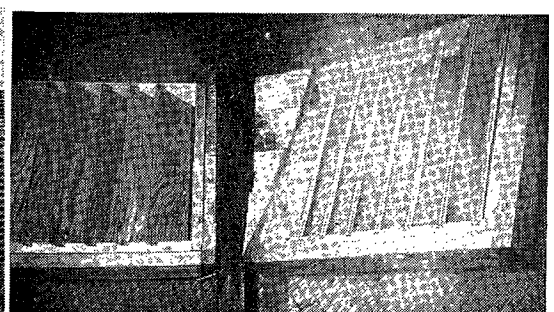
写真 8 気流変更板取付状態 Photo. 8 A view of damper unit
