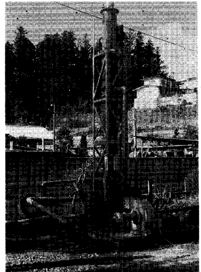
写真1 長野県鹿島予備水源池向
