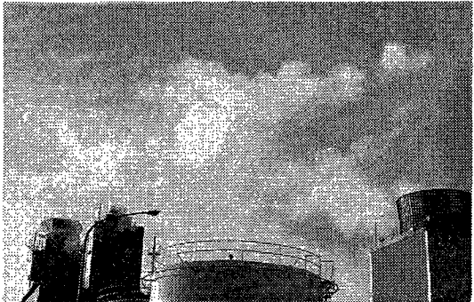
写真 7 CASE NO.2 湿式運転 Photo.7 Wet operation
