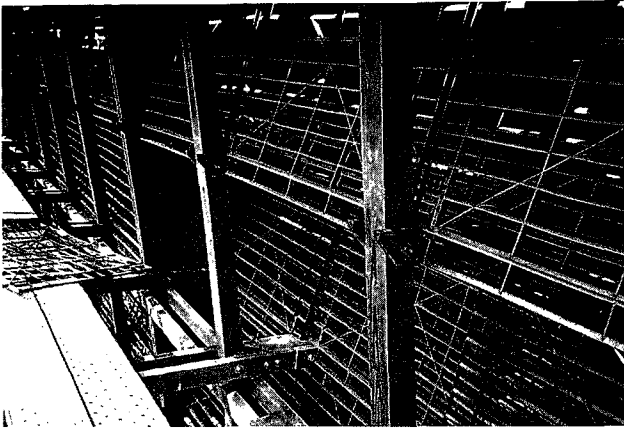
写真 7 充填材 Photo.7 Fill
