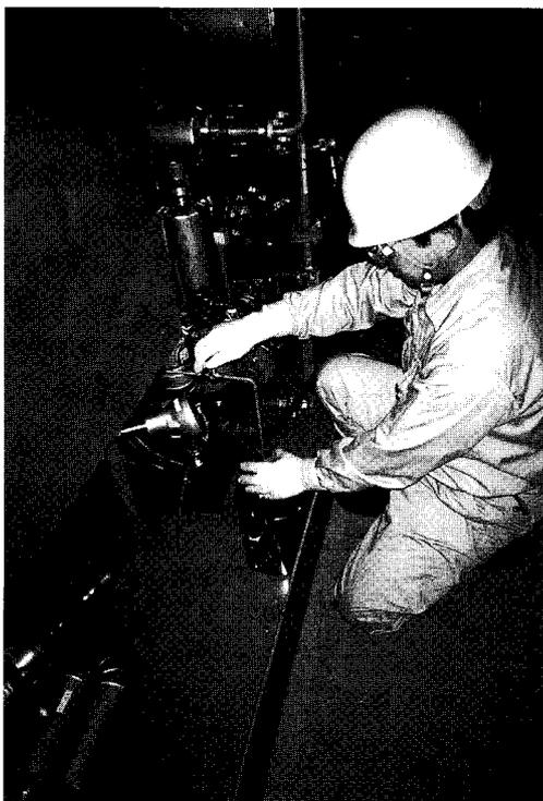
写真3 処理油のサンプリング状況
