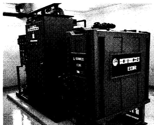
写真1 EDR(宮原簡易水道)
