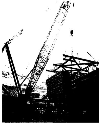
写真 4 クローラクレーンによる吊り上げ (1回目)
