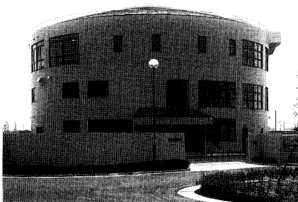
写真1 管理棟 Photo.1 Control building
