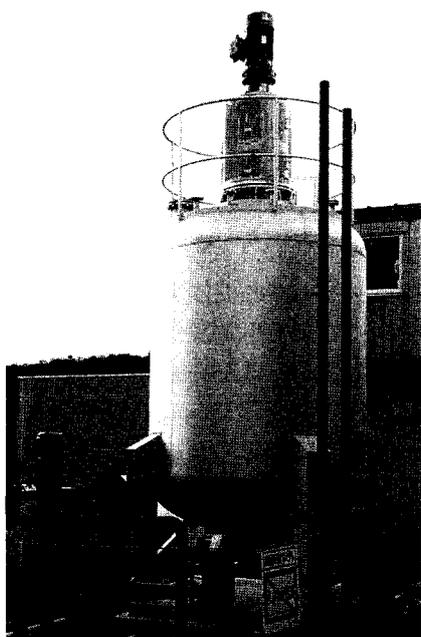
写真2 廃液受入供給貯槽
