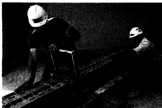
写真5 Type Sの接続据付方法 Photo.5 Type S installation
