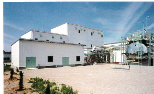
SD工場 Sodium Dispersion Plant
