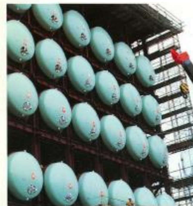
100m³ ビール貯蔵タンク
