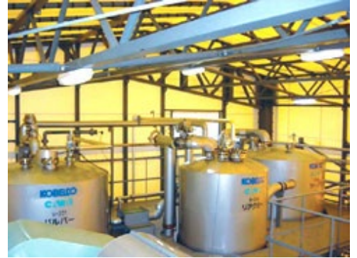
2005年3月 建設技術審査証明事業を 汚泥可溶装置について取得しました。
