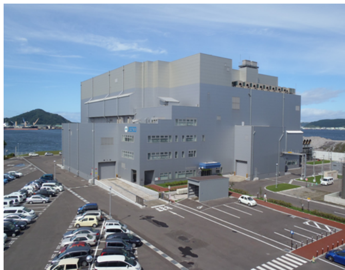
北海道 PCB 廃棄物処理施設外観 (写真提供：日本環境安全事業株式会社)
