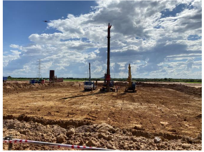
浄水池建設予定地
