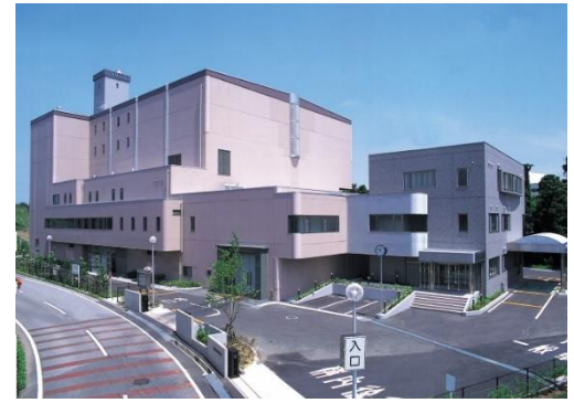
クリーンセンターしらさぎ 外観
