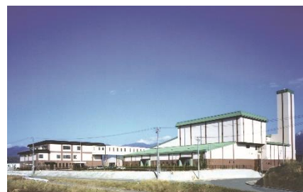
中津川市環境センター 外観
