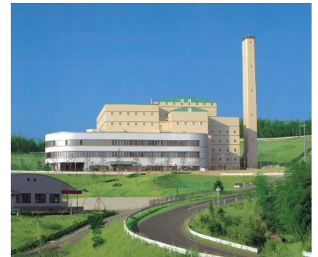
吉備路クリーンセンター 外観
