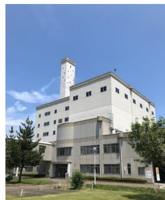
妙高クリーンセンター 外観
