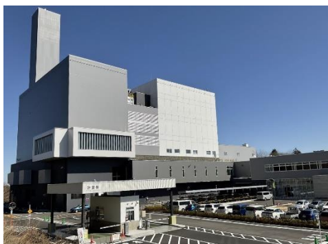
埼玉西部クリーンセンターの外観
