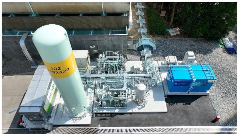
本実証は、冷熱発電<sup>※2</sup>による電力を活用し、HHOGで水素（H<sub>2</sub>）を発生させます。その水素と知多市南部浄化センターで発生するバイオガス由来の二酸化炭素（CO<sub>2</sub>）を原料としてe-メタンを製造するものであり、CO<sub>2</sub>を地域資源として活用する環境性の高い取り組みです。
