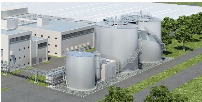
【汚泥消化施設】
