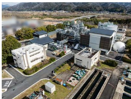
【完成した施設の外観】
