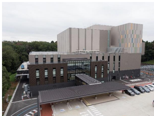
【館クリーンセンターの外観】
